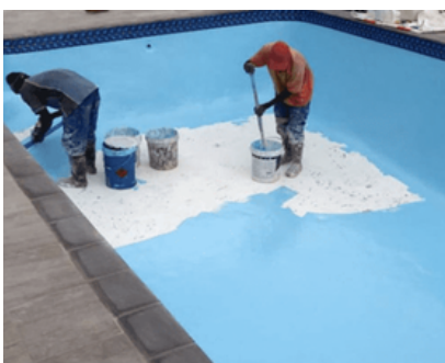
Thi công chống thấm hồ bơi/bể bước bằng PU Eco
