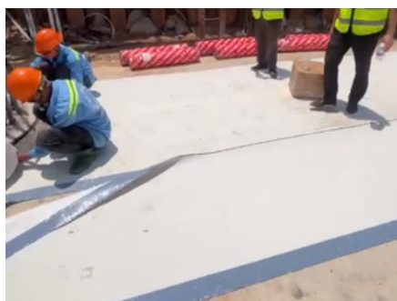
Thi công chống thấm sàn mái/sàn hầm bằng màng gốc TPO
