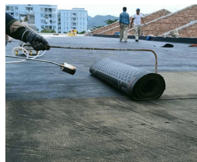
Thi công chống thấm mái bằng màng bitum khô nóng
