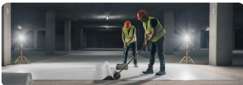
Thi công chống thấm hầm bằng màng HDPE
