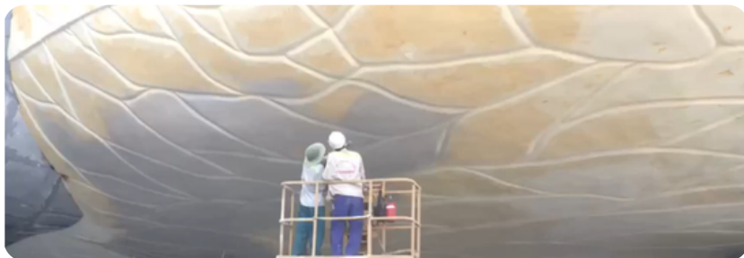
Thi công chống thấm bằng công nghệ Polyurea
